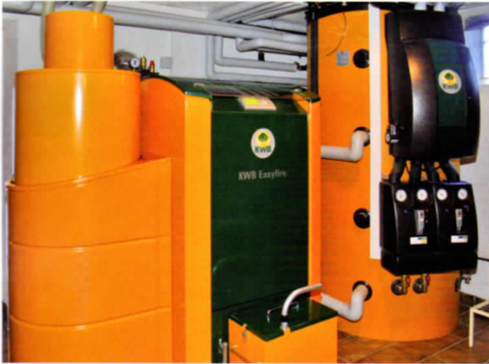
Kompakte Anlage: Vorratsbehälter, Pelletskessel und Pufferspeicher (v.l.) sind die Kernelemente der Heizung. Die Pellets gelangen über zwei Schläuche vom Pelletsbunker (siehe Bild rechts am linken Rand) zur Anlage
