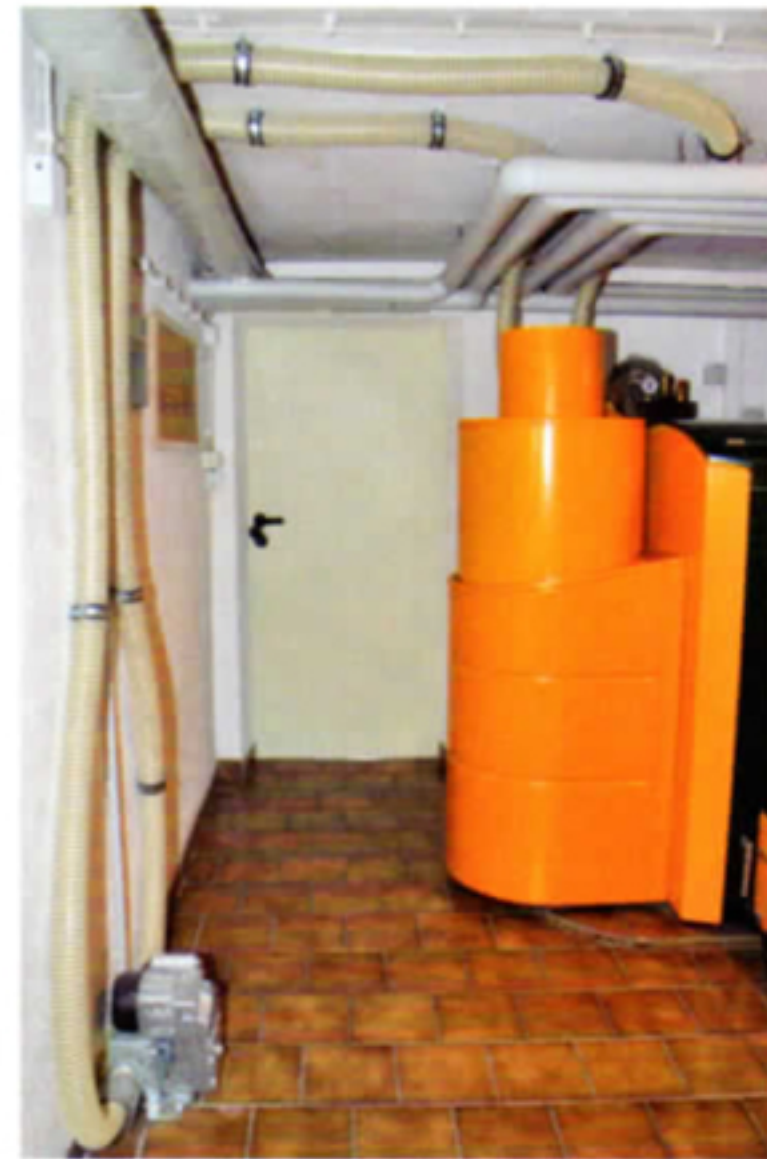
Kompakte Anlage: Vorratsbehälter, Pelletskessel und Pufferspeicher (v.l.) sind die Kernelemente der Heizung. Die Pellets gelangen über zwei Schläuche vom Pelletsbunker (siehe Bild rechts am linken Rand) zur Anlage
