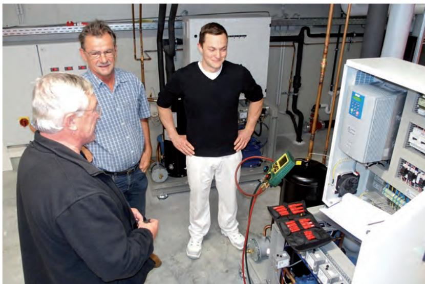
serstationen wird das Wasser im Durchfluss mit 75 Grad Celsius erhitzt. Die Gefahr, dass sich gesundheitsschädliche Legionellen ansiedeln, besteht damit nicht. Die im Sommer 2016 neu installierte Kälteanlage hat eine Kälteleistung von 30 Kilowatt und eine elektrische Leistung von 22 Kilowatt.
