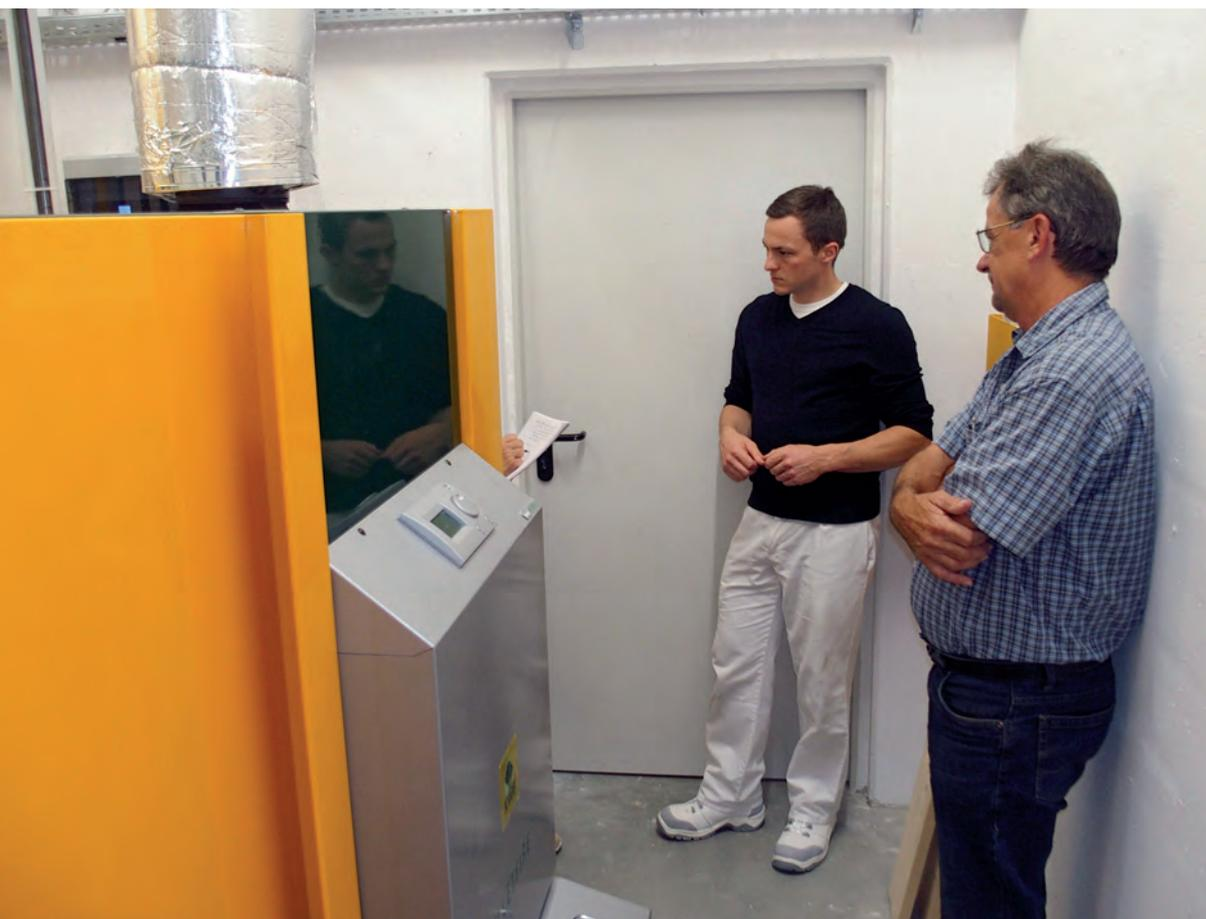
Im Heizungsraum arbeiten zwei Pelletskessel mit je 155 Kilowatt Leistung
